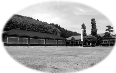
右側の建物(明治36年竣工)の屋根は、平成26年度日本郵便の年賀寄附金の助成を受けて改修しました。
